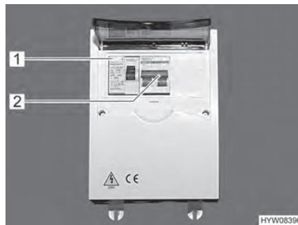
Fig. 116 Coffret de fusibles 230 V avec disjoncteur de protection de circuit et disjoncteur FI
