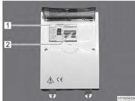
Fig. 104 Scatola dei fusibili a 230 V con interruttore di sicurezza e interruttore automatico FI
