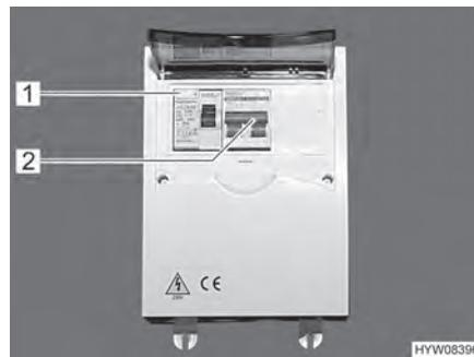
Bild 109 230-V-Sicherungskasten mit Leitungsschutzschalter und FI-Schalter
