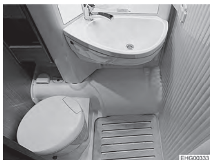
Bild 143 Toalettstol, vriden mot väggen
