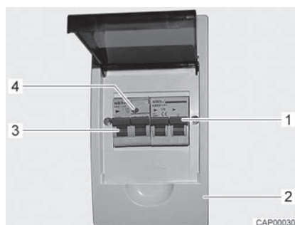
Fig. 51 Disjoncteur de protection de circuit et disjoncteur FI (coffret de fusibles 230 V)
