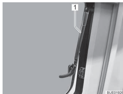
Bild 12 Överkantshängt fönster med automatik-spärrar, öppet
