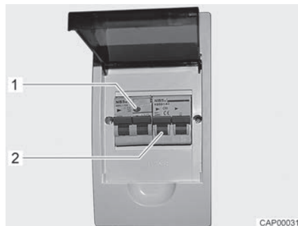
Fig. 56 Scatola dei fusibili a 230 V con interruttore di sicurezza e interruttore automatico FI
