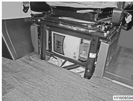
Fig. 53 Emplacement du coffret de fusibles 230 V
