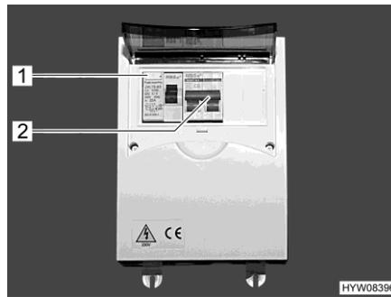
Fig. 109 Scatola dei fusibili a 230 V con interruttore di sicurezza e interruttore automatico FI
