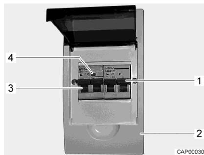
Fig. 74 Interruttore di sicurezza e interruttore automatico FI (scatola dei fusibili a 230 V)
