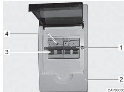
Fig. 66 Disjoncteur de protection de circuit et disjoncteur FI (coffret de fusibles 230 V)
