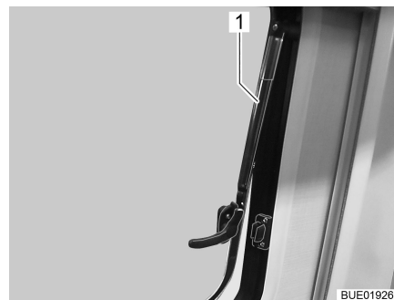
Bild 14 Överkantshängt fönster med automatik-spärrar, öppet
