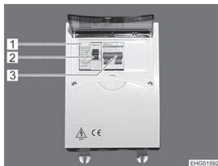
Fig. 171 Coffret de fusibles 230 V avec disjoncteur de protection de circuit et RCD (interrupteur principal)
