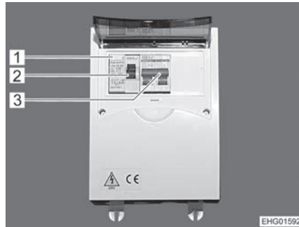
Bild 171 230 V-säkringslåda med ledningsskyddsbrytare och RCD (huvudbrytare)
