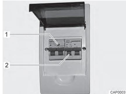
Fig. 61 Caja de fusibles de 230 V con interruptor de protección de línea e interruptor FI
