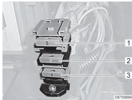
Bilde 104 Sikringer ved siden av strømsentralen
