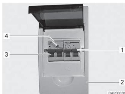
Fig. 51 Disjoncteur de protection de circuit et disjoncteur FI (coffret de fusibles 230 V)
