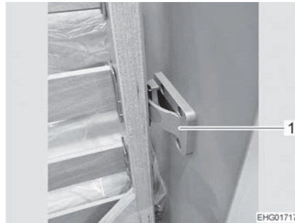
Bilde 61 Låsemekanisme (våtromsvegg)
