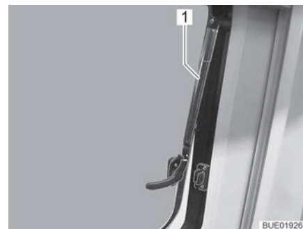
Bilde 30 Vindu som kan åpnes utover med armer med automatisk låsing, åpent
