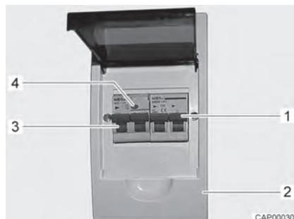
Fig. 78 Interruttore di sicurezza e interruttore automatico FI (scatola dei fusibili a 230 V)
