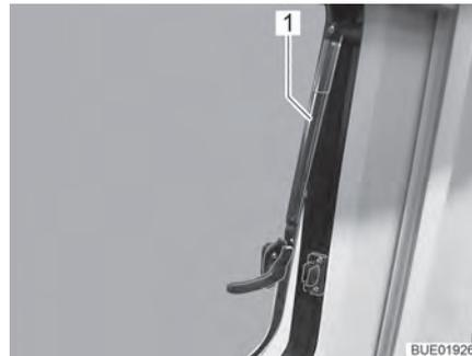
Fig. 19 Fenêtre projetante avec bras automatiques, ouverte
