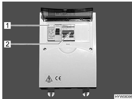
Bild 76 230-V-Sicherungskasten mit Leitungsschutzschalter und FI-Schalter
