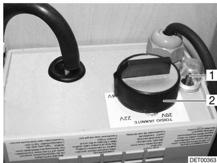
Bild 86 Regler für elektrische Fußbodenheizung
