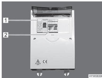
Fig. 88 Caja de fusibles de 230 V con interruptor de protección de línea e interruptor FI
