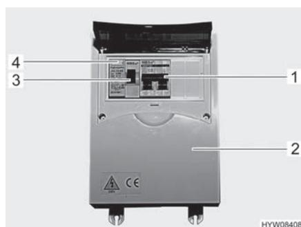
Fig. 82 Caja de fusibles de 230 V con interruptor de protección de línea e interruptor FI
