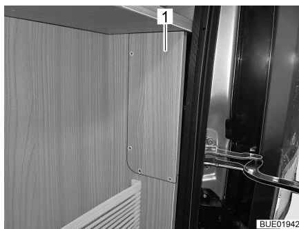
Bilde 84 Tilgang til baklys, høyre
