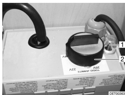
Fig. 89 Regolatore per riscaldamento elettrico del pavimento
