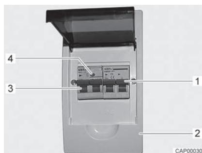
Fig. 51 Interruptor de protección de línea e interruptor FI (caja de fusibles de 230 V)
