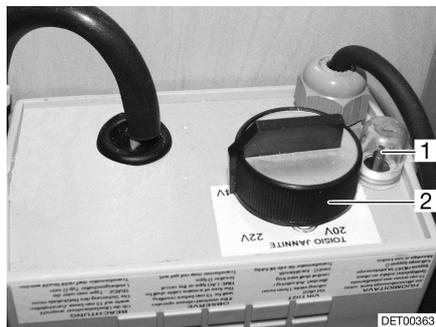
Fig. 86 Régulateur du chauffage électrique du plancher
