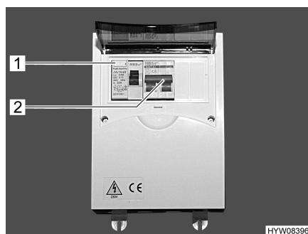
Fig. 76 Scatola dei fusibili a 230 V con interruttore di sicurezza e interruttore automatico FI
