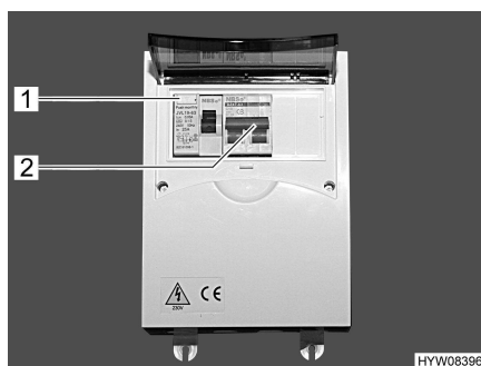
Afb. 76 230-V-zekeringenkast met beveiligingsautomaat en FI-schakelaar
