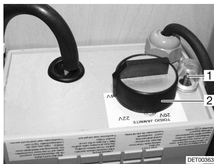
Kuva 86 Sähköisen lattialämmityksen säädin
